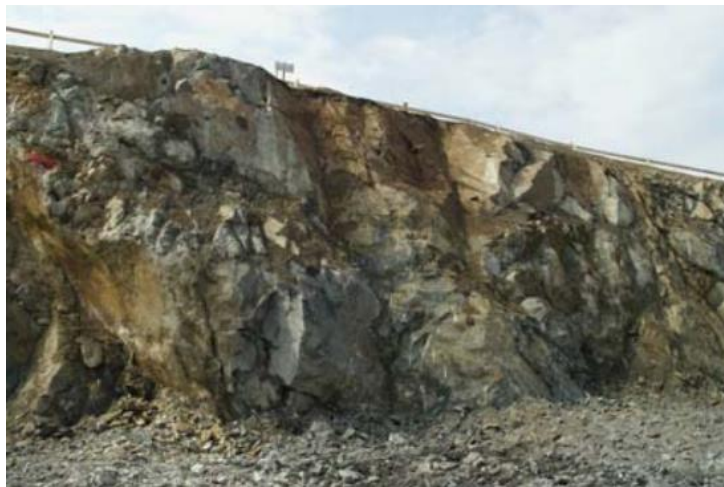
Imagem 1: Talude Oeste da escavação, L. Marik photography
