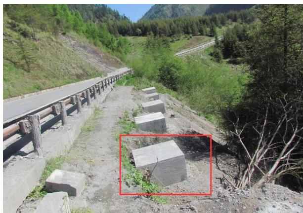
Estacas anti-deslizantes (totalmente abaixo da superfície)
