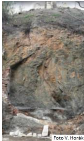
Visualização do talude rochoso – secção transversal em análise
